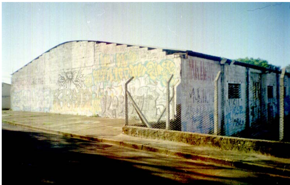
Fig. 84— A sede nova ou a “de baixo” localizada na rua Ataulfo Alves.
