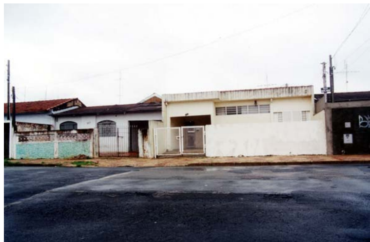
Fig. 63. As alterações de fachada modificam completamente o estilo original das casas. Em uma mesma rua vemos casa que ainda mantém o telhado origina (centro), ao lado das que os moradores já substituíram as telhas de amianto por barro e os que esconderam completamente o telhado.
