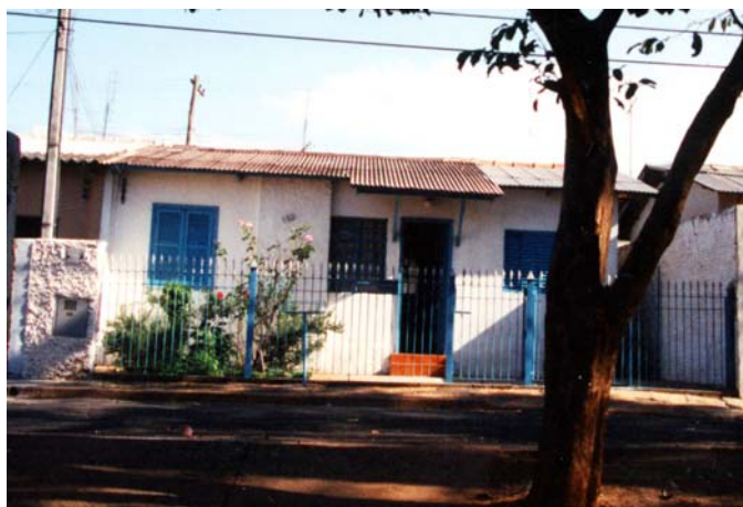
Fig. 52 - Casa com fachada próxima da original e seguindo a orientação dada pela Cohab na época para a ampliação dos imóveis (quarto do lado direito). Do lado esquerdo, permanece a utilização conjunta do poste de ligação de energia.
