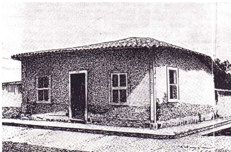
Figuras 5 – Nos cantos da casa e em determinados pontos intermediários erguiam-se colunas de madeira cortadas de um só tronco. (Pupo, Celso; 1969:87)
