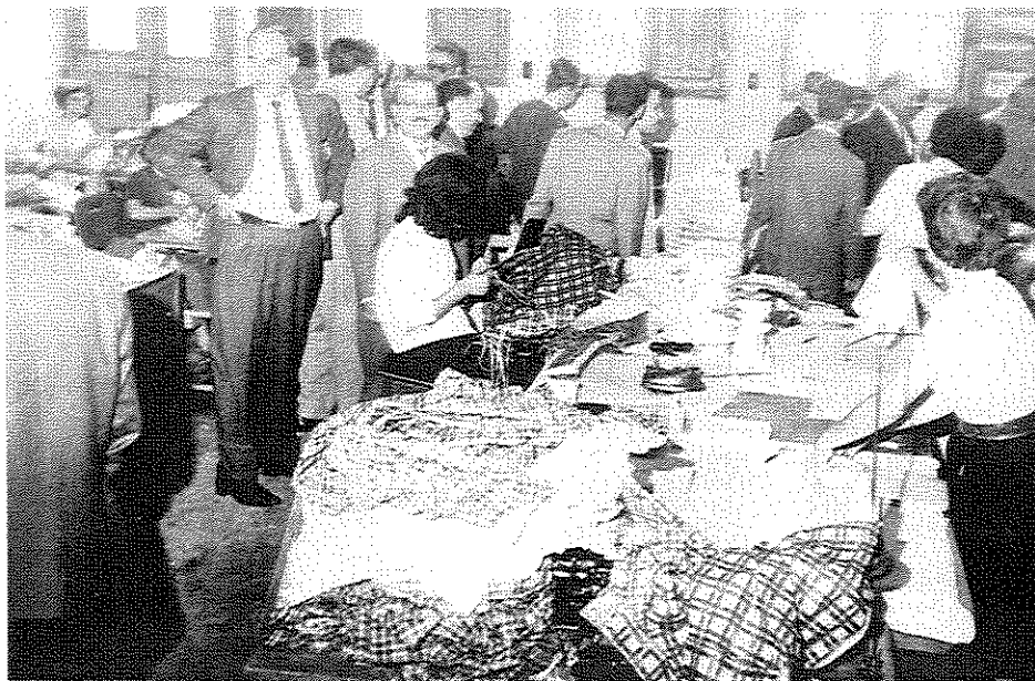
Foto 17 - Fábrica de confecções em Santa Maria, que funcionou na rua Ernesto Beck, no prédio que foi construído para a padaria e que foi utilizado pela escola, pela fábrica de café e, posteriormente, pela fábrica de confecções. O prédio ainda existe e no local funciona um templo de seita sei-cho-noiê. Foto da década de quarenta: acervo da Cooperativa.
