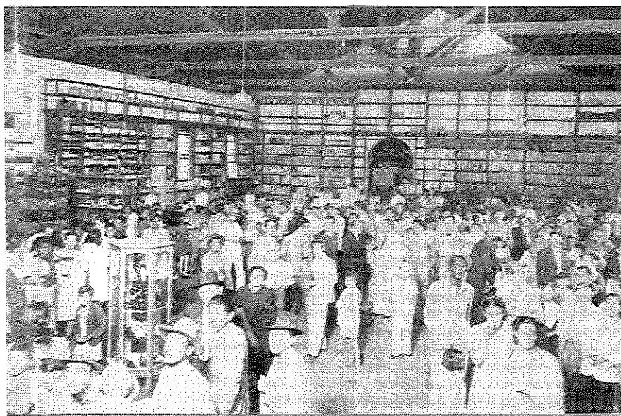
Foto 03 - Interior do Armazém Central, prédio da foto 01. Era grande o número de esposas e filhos de associados que ali iam fazer compras para as famílias, além dos próprios associados que eram a maioria. Foto da década de quarenta: acervo da Cooperativa.
