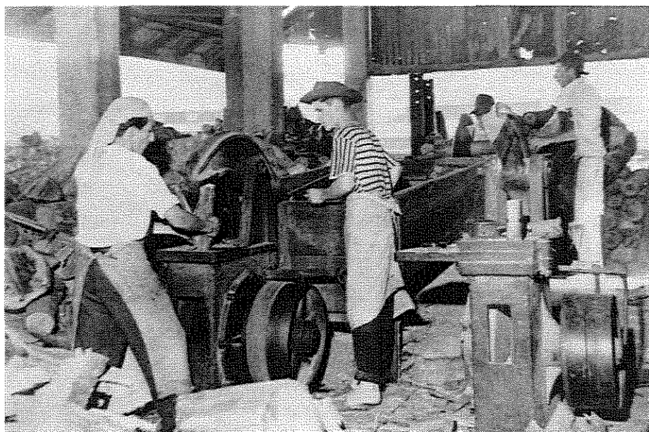
Foto 19 - Machado mecânico utilizado para picar a lenha que era fornecida pela Cooperativa. O objetivo da Cooperativa neste caso foi o de estabelecer uma regularidade no fornecimento de lenha para os associados. Foto da década de quarenta: acervo da Cooperativa.
