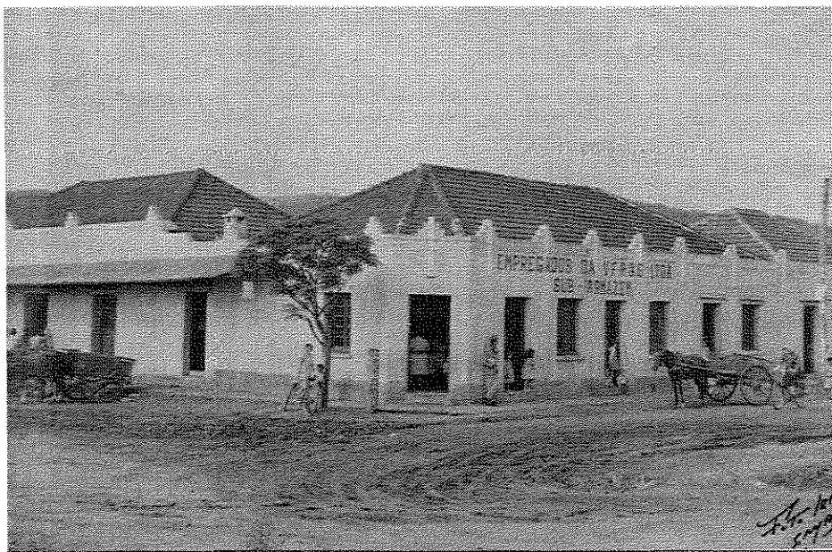
Foto 08 - Subarmazém de Inspetor Goulart. O prédio fica na confluência da Av. Borges de Medeiros com a linha férrea. Hoje não pertence mais à Cooperativa, foi vendido para particulares e ali funcionam uma mercearia e um estúdio fotográfico. Foto da década da quarenta: acervo da Cooperativa.
