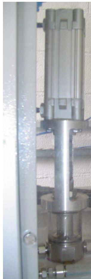
Figura 6.1: Bomba pneumática de propano. (a) Esquema da bomba, (b) foto da bomba instalada na planta piloto
