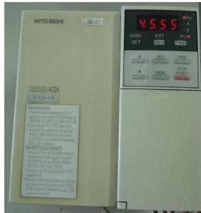
Figura 3.6 – Inversor de frequência do motor em balanço
