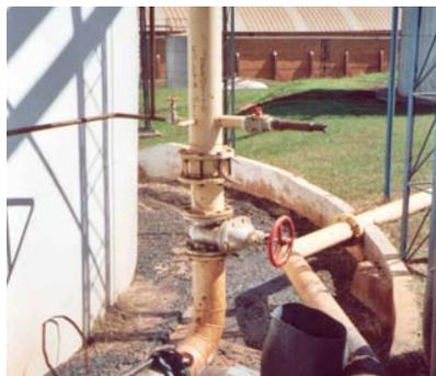
Figura 8: Válvula lateral para retirada de amostra do biorreator.
