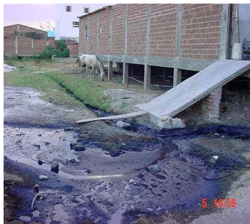
Figura 3.2: Detalhe do lançamento dos efluentes.
