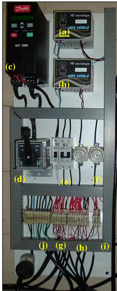
**Figura 1.16: Painel: (a e b) fontes de alimentação, (c) inversor de frequência, (d) chave, (e) disjuntores, (f) fusíveis, (g, h, i e j) réguas de bornes.**
