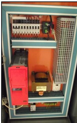
**Figura 3.6** Quadro elétrico com conversor de frequência da planta piloto do L-EFD
