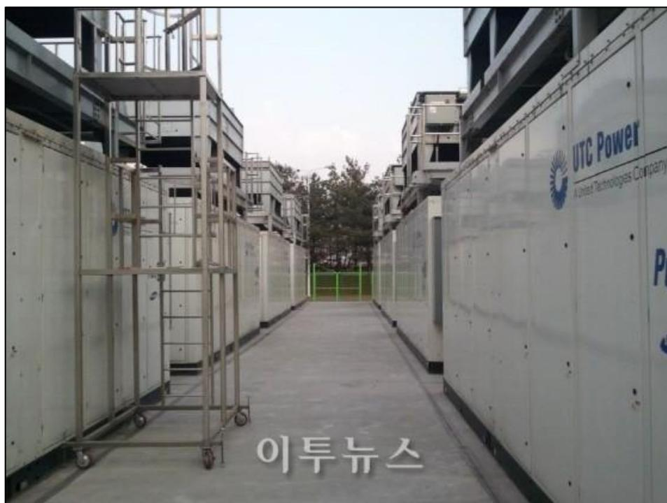
Figura 12 – Pilha tipo PAFC, em uma fábrica na Coreia do Sul.
