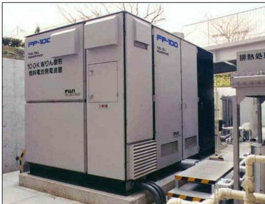
Figura 11 – Instalação de uma PAFC em na fábrica da Fuji-Eletric.
