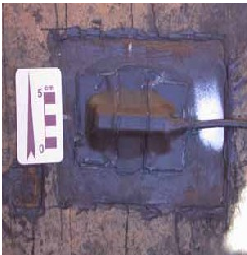
Figura 12: Duto instrumentado com extensômetro Fonte: Cesec, 2006
