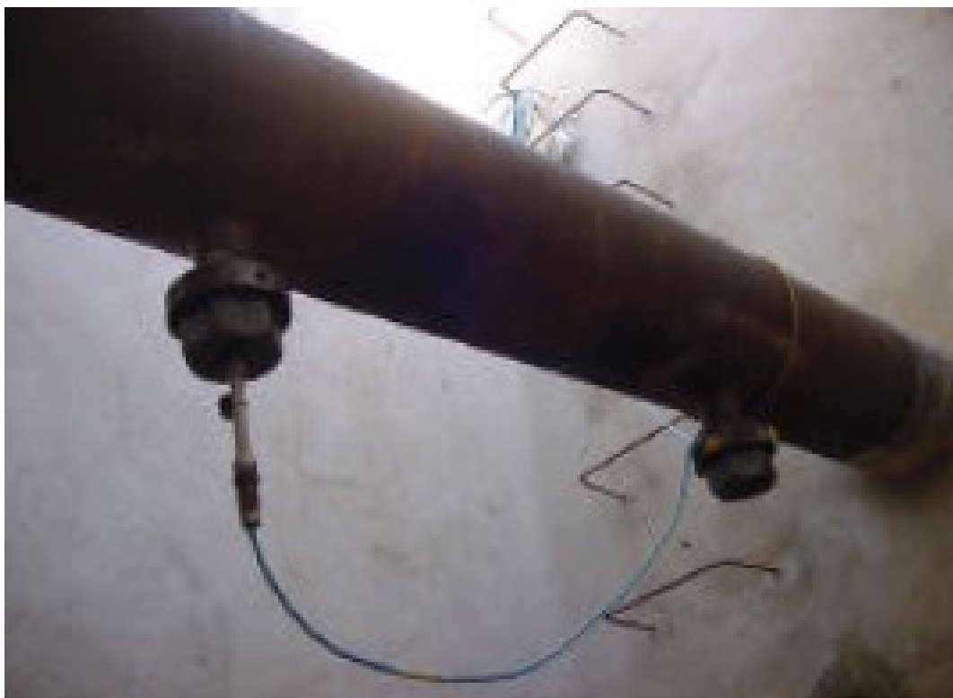
Figura 10: Caixa de inspeção com sistemas de monitoramento instalado em campo
