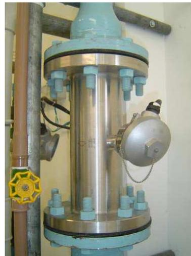
(d) Medidor de vazão de gás
