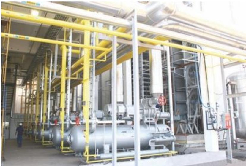
**Figura 1. Sistema de refrigeração indireto. Os *chillers* são responsáveis por refrigerar o fluido secundário que será usado como utilidade fria nos processos**
