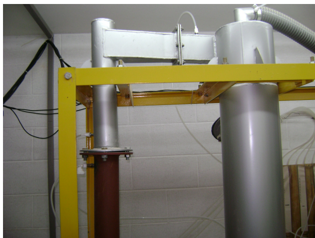
Figura 3.4: Saída abrupta da seção riser da Unidade Multipropósito.
