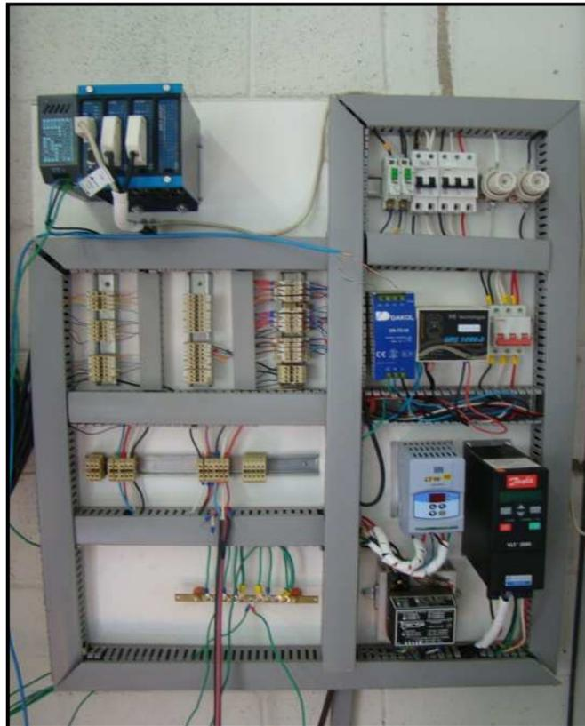
FIGURA 2.25. Montagem do painel elétrico de comando
