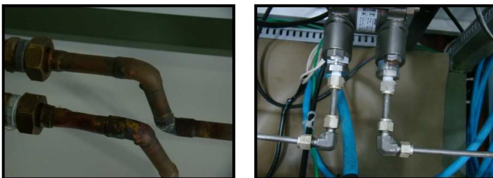
FIGURA 2.6. Montagem das linhas de (a) cobre e (b) inox.
