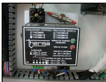
FIGURA 2.11. Variador de potência utilizado no sistema de polimerização.
