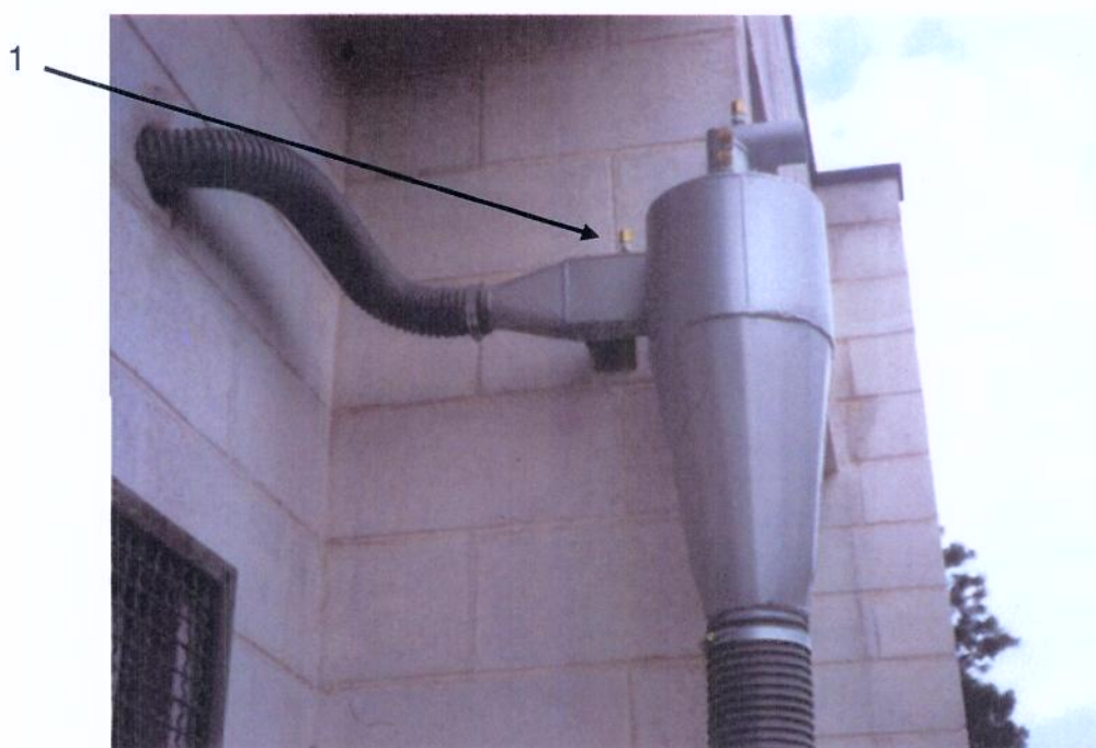
Figura 3.13: Ciclone secundário (1 – detalhe da tomada de pressão).
