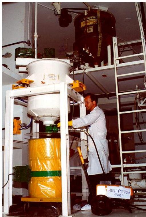
Figura 3.43 - Sistema de cimentação do CDTN.
