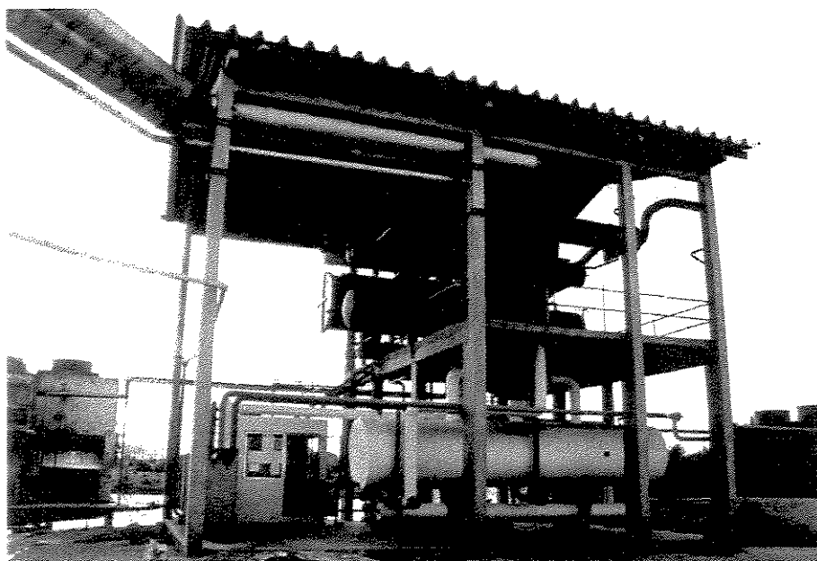
Figura 1.1 - Vista geral da instalação de absorção do FRIGORÍFICO EXTREMO SUL de Pelotas, RS (Mühle, 1998).
