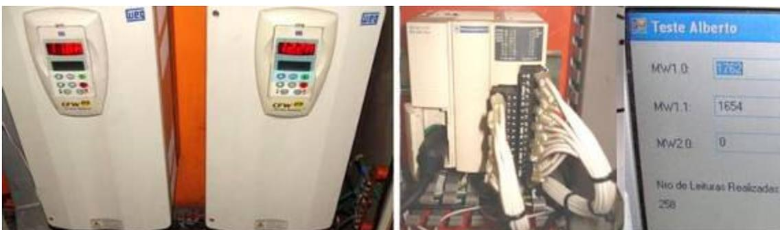
Figura 3.4: Inversores de frequência WEG - CFW09 e CLP Twido TWDLMDA20D-K mais duas placas de entradas analógicas TWDAMM3HT
