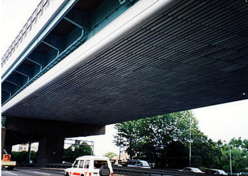
Figura 2.7: Viaduto com aplicação de espumas de alumínio Alporas em partes estruturais para absorção de ruídos (SHINKO-WIRE, 2007).
