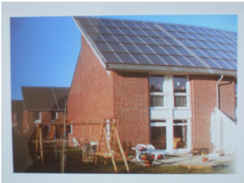
Figura 2.6 Placas de um Sistema de Aquecimento Solar (GERHART, 1999).
