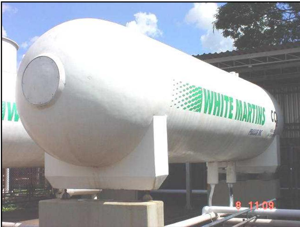
Figura 3.1 – Vaso de CO<sub>2</sub> fabricado em 1994.
