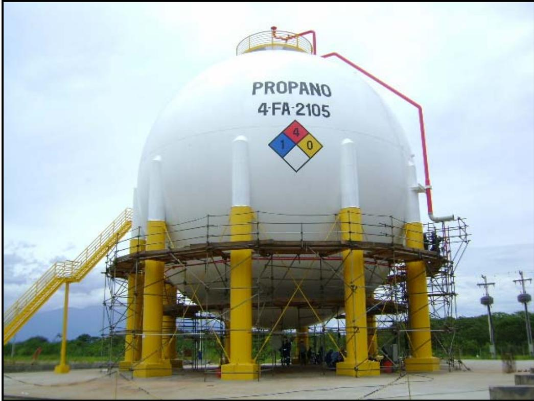
Figura 3.13 – Exemplo de um Vaso Esférico.
