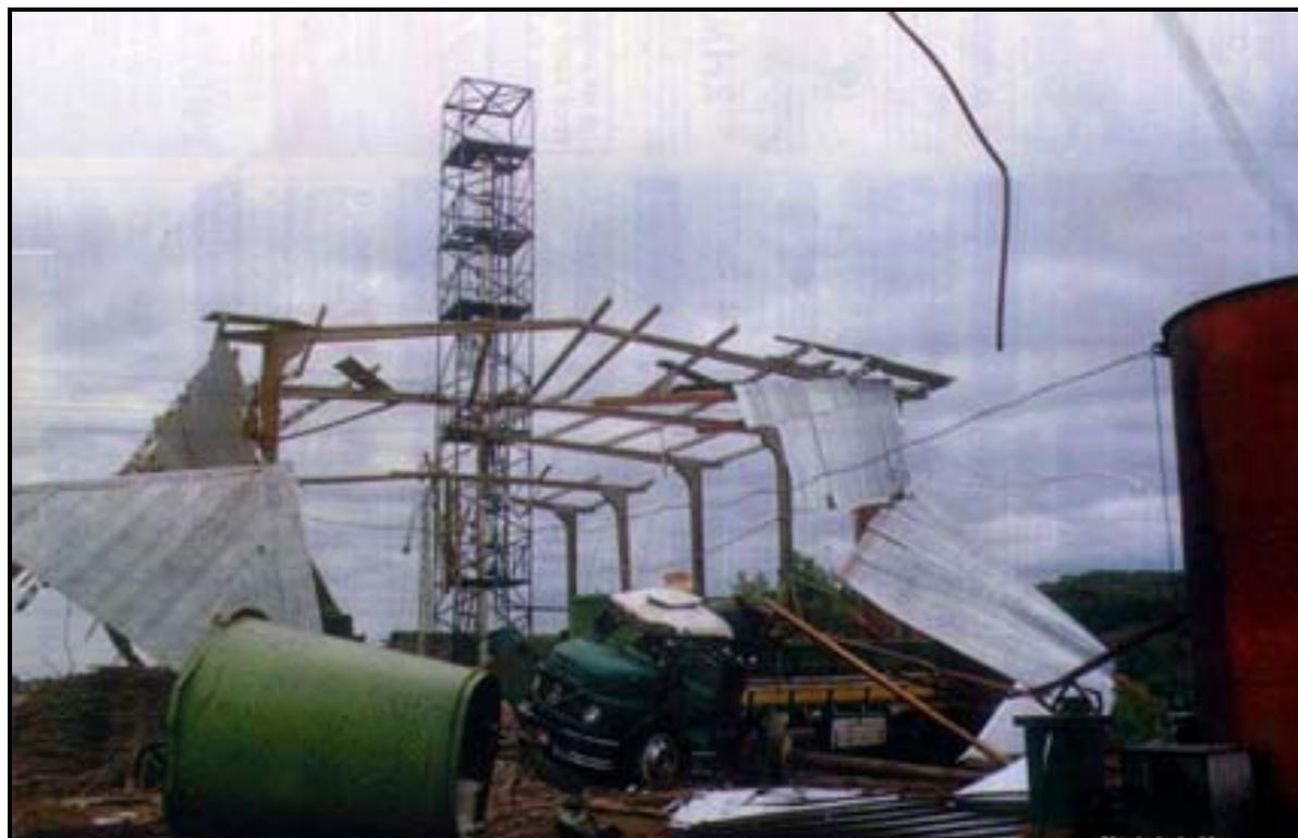
Figura 2.5 – Destroços após Explosão.
