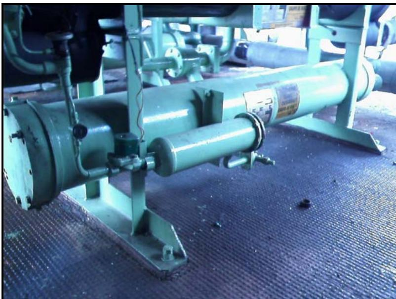
Figura 3.10 – Evaporador do Chiller Industrial.
