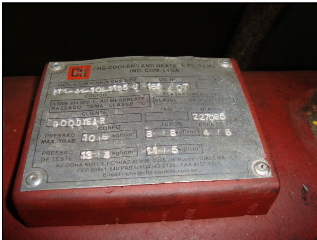
Figura 3.46 – Placa do Fabricante de um Trocador de Calor.
