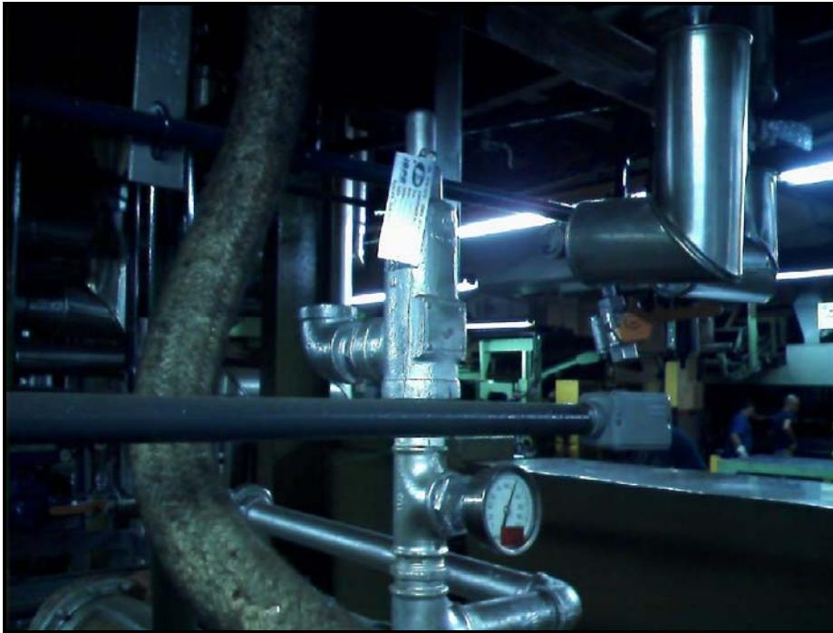
Figura 3.18 – Válvula de Segurança de um Trocador de Calor.
