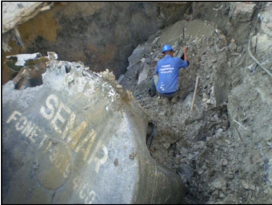
Figura 2.7 – Tanque de armazenamento de óleo.
