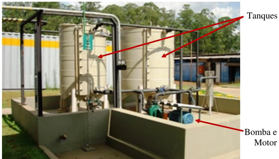
**Figura 3.3:** Foto dos tanques e do conjunto bomba e motor do sistema de injeção de líquido.
