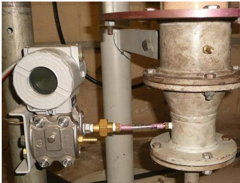
Figura 3.6 – Transdutor de pressão no *plenum*.
