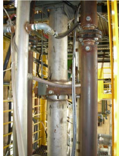
Figura 3-8 Trocadores de calor
