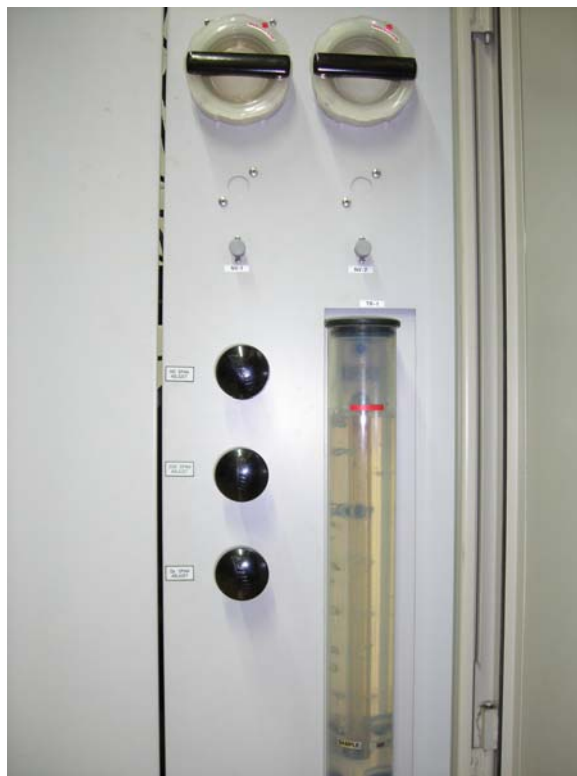
Figura 2.2 Reservatório dianteiro de água
