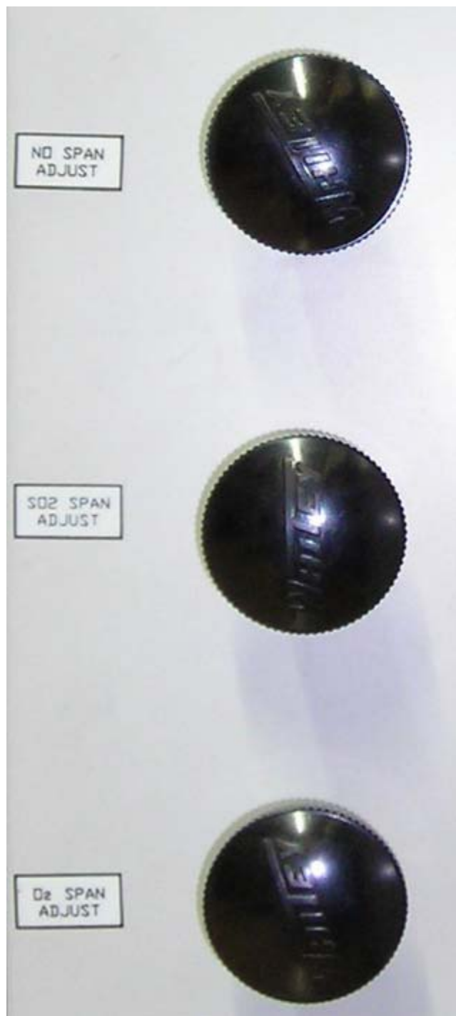
Figura 3.6 Válvula de regulagem do gás de calibração
