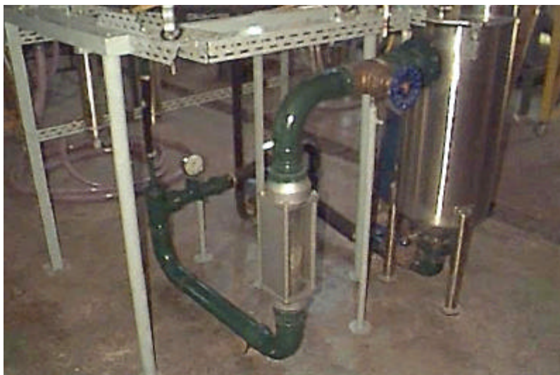
Figura 2.14 - Linha de desvio com manômetro na saída da bomba, rotâmetro e válvula de controle
