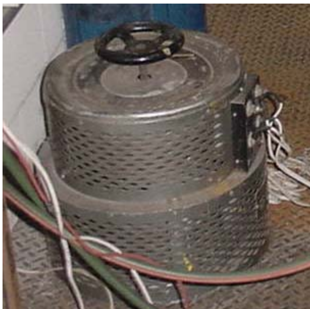
Figura 5. 12: Controlador de Tensão
