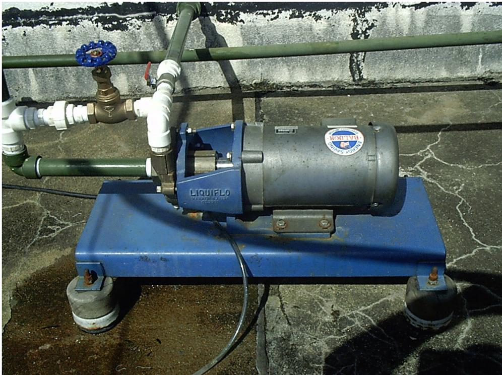
Figura 3.4: Bomba centrífuga usada no bombeamento da fase líquida.
