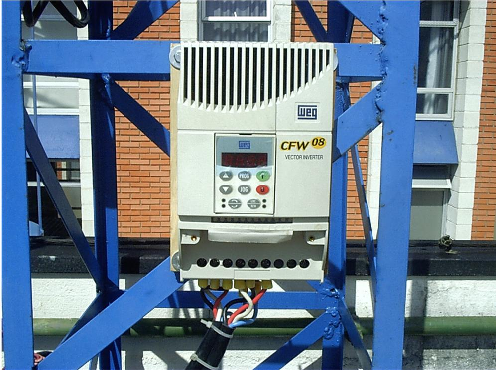
Figura 3.10: Inversor de frequência.
