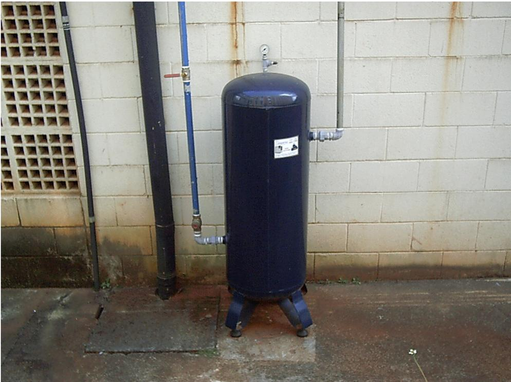
Figura 3.3: Tanque pulmão.
