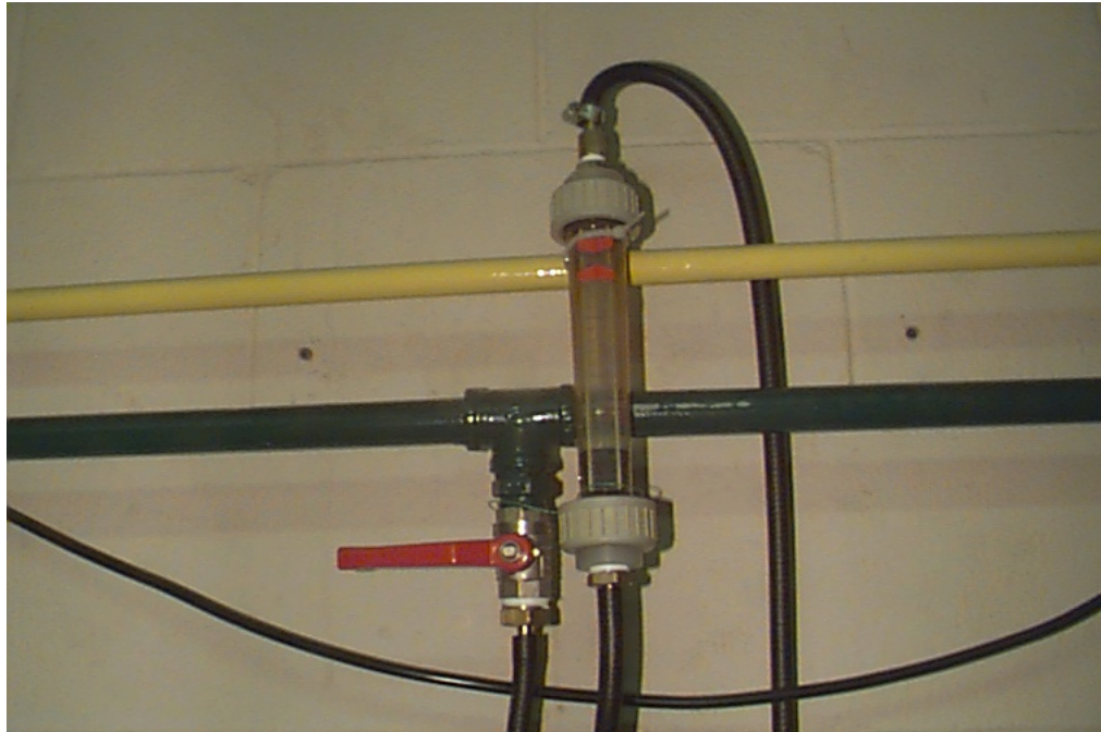
Figura 3.27 Rotâmetro para água
