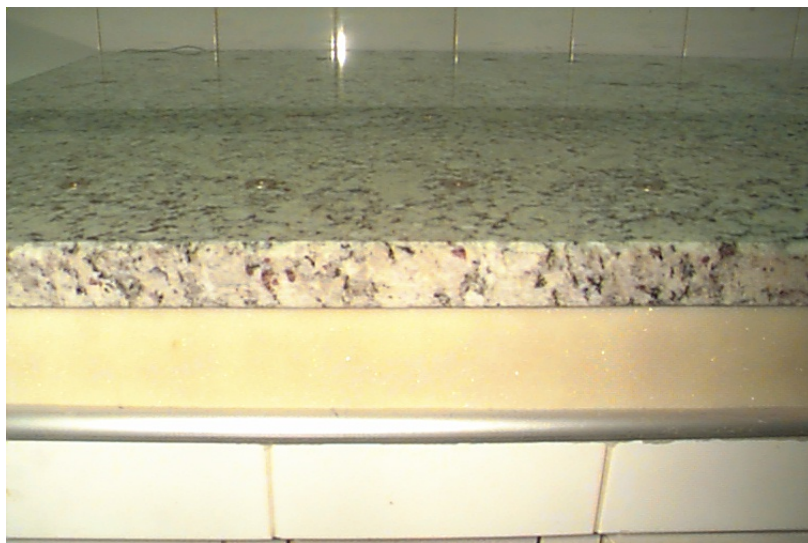
Figura 3.24 Espuma sob a placa de mármore da bancada
