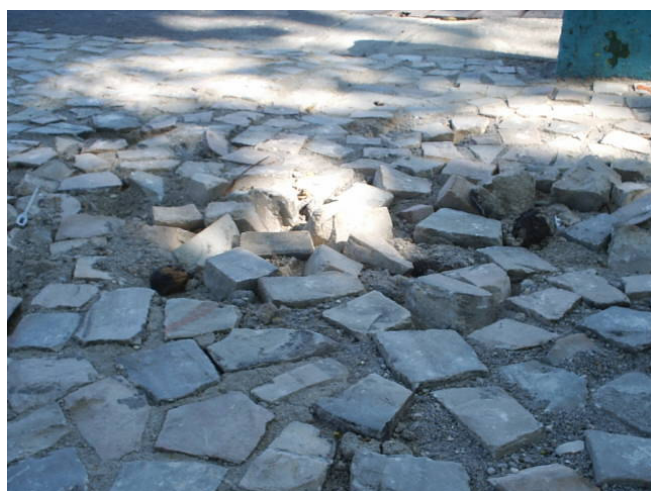
Figura 6.3 Buraco na calçada e rampa inadequada de mobiliário urbano que dificulta a circulação do usuário de cadeira de rodas. (Manual de Referência, 2006)
