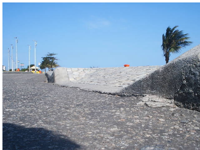
Figura 6.3 Buraco na calçada e rampa inadequada de mobiliário urbano que dificulta a circulação do usuário de cadeira de rodas. (Manual de Referência, 2006)
