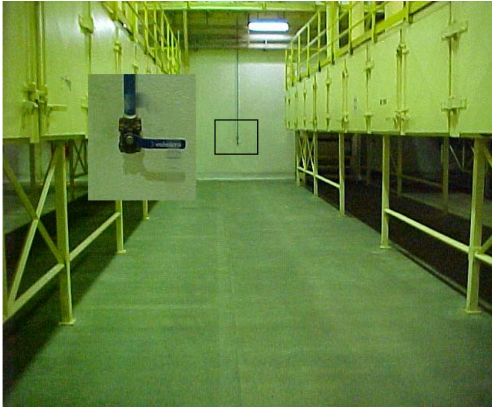
Figura 4.11: Foto da área dos fornos após as melhorias – Mogi-Mirim 2003
