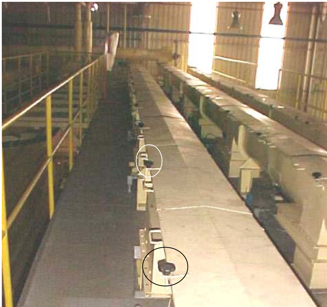
Figura 4.12: Foto das roscas transportadoras antes da melhoria - 2001
