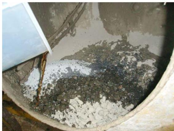
Figura 3.14 – Colocação da água e do fluidificante
