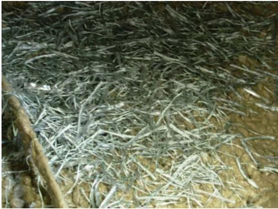
Figura 3.15 – Colocação das fibras sintéticas
