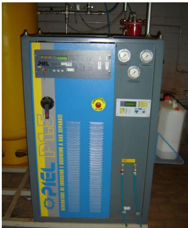
Figura 3.5 - Eletrolisador bipolar alcalino da empresa italiana *Piel*. (Fonte: LH2/UNICAMP)
