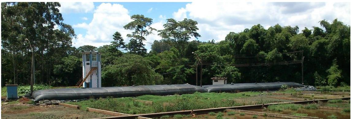
Figura 2.3 Bolsões para desidratação do lodo de esgoto na ETE Carioba. Fonte: o autor
