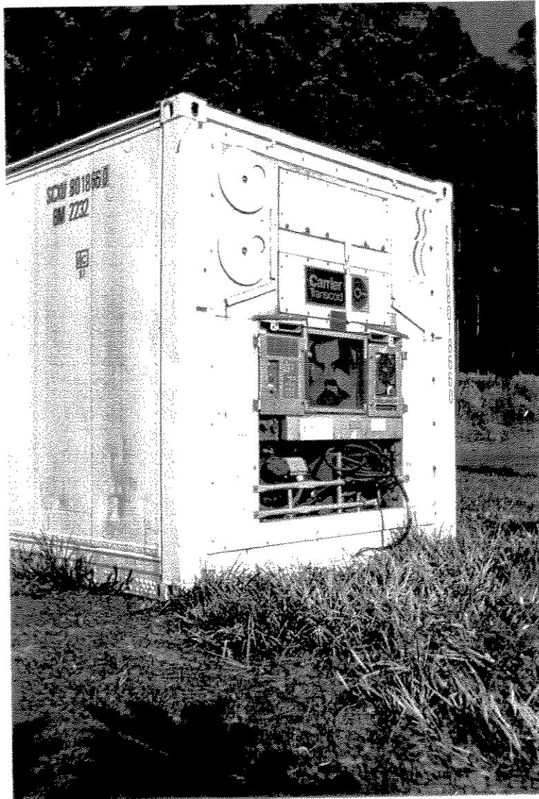
Foto 3. Vista posterior do Container Frigorífico. Na foto o sistema de refrigeração e as portinholas de renovação de ar.
