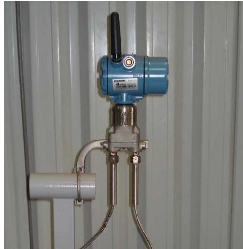
Figura 3.15 Sensor diferencial de pressão com transmissão wireless acoplado à linha de teste.
