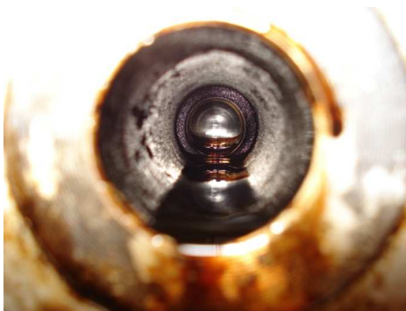
Figura 3.25 Imagem da parte interna da tubulação após procedimento de limpeza da linha.
