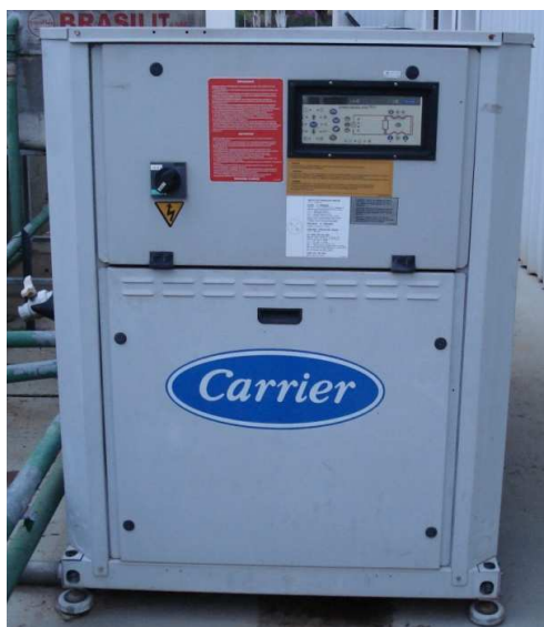
Figura 3.16 Equipamento utilizado para controlar a temperatura da água do banho durante os testes de repartida e limpeza da linha.
