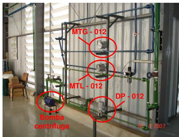
Figura 3.4 – Bomba centrífuga e medidores de vazão.
