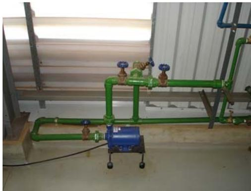
Figura 3.3 – Bomba centrífuga e registros de controle com *by pass*.
