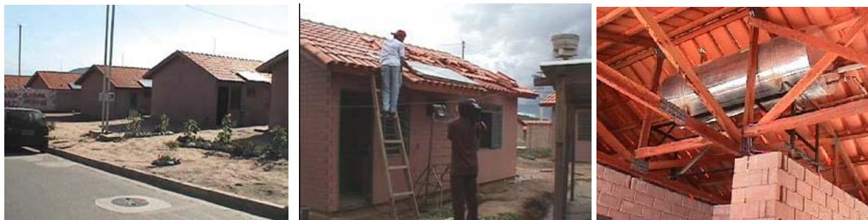
Figura 5.5 O sistema termossolar convencional, com o coletor apoiado no telhado e o reservatório no interior da moradia, em 2000, no Projeto Sapucaias. Fonte: Pereira et al., 2003b.
