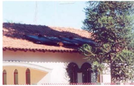
Figura 4.25 Estado de conservação do coletor - vidros quebrados e oxidação da caixa de alumínio (em 6% da amostra) - e sombreamento, em Campo Mourão-PR. Fonte: Widderski, 2002.
