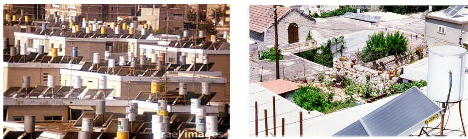
Figura 2.13 Coletores com reservatórios cilíndricos nos telhados de Telaviv<sup>17</sup>, em Israel. Fotos: Israelimages, 2004.
