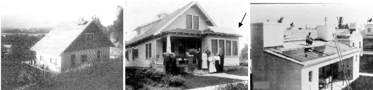
Figura 2.3 Coletor solar em residência datada de 1896. No centro, residência na Califórnia, em 1911, com o *Clímax Solar-Water Heater* colocado na varanda da moradia. À direita coletores que eram instalados na Califórnia, entre 1920 e 1940. Fonte: Perlin, 2005.
