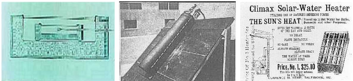
Figura 2.2 Estudos de Saussure em 1760. No centro, o primeiro protótipo. À direita o primeiro coletor, patentado por Kemp, já colocado para venda comercial em 1891. Fonte: Perlin, 2005.
