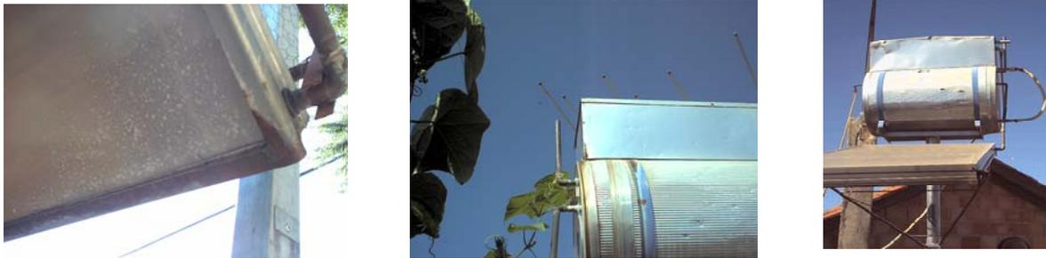
Figura 5.27 Oxidação na estrutura da caixa da placa coletora, falta de limpeza nos vidros da placa e reservatório danificado por pedras.
