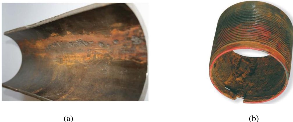
Figura 2.6 – Pites de corrosão em uma coluna de produção (a) e tubulação utilizada na injeção de água em reservatórios (b) (Bellarby, 2009).
