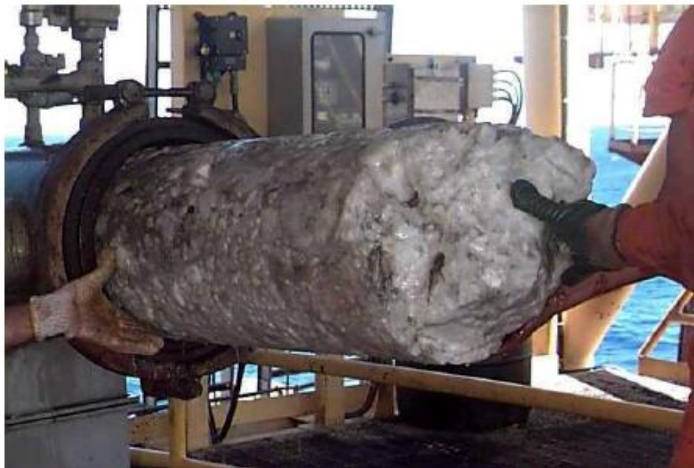
Figura 2.4 – Pistão de hidrato formado em um gasoduto (Labanca, 2005).
