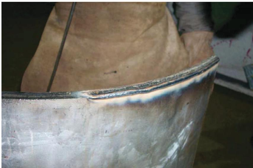
Figura 2.10 – Aplicação de amanteigamento na superfície do chanfro da dupla calha.
