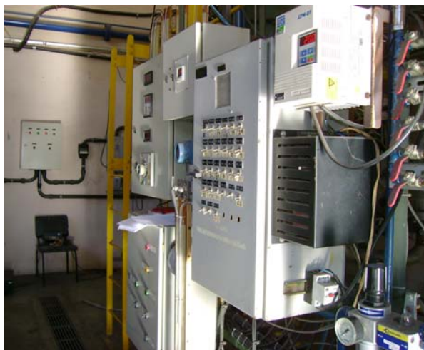
Figura 3-13 Sistema de leitura de pressão estática.
