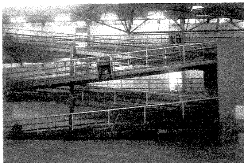
Figura 2.3 Exemplo de local com rampas.
