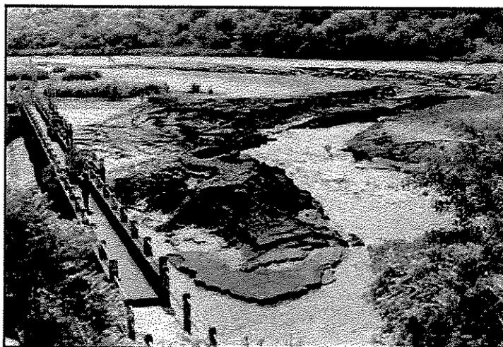
Figura 2.3 – Vista geral do assoreamento e da ensecadeira formadas pelos depósitos em frente à tomada de água (Chella, M.R.; Ota, J.J. e Povh, P.H.,2003)
