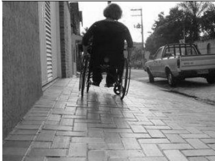
Figura 2.10 Usuária de cadeira de rodas circulando com dificuldade pela calçada com piso transversal inclinado mais que o permitido. (Manual de referência, 2006)
