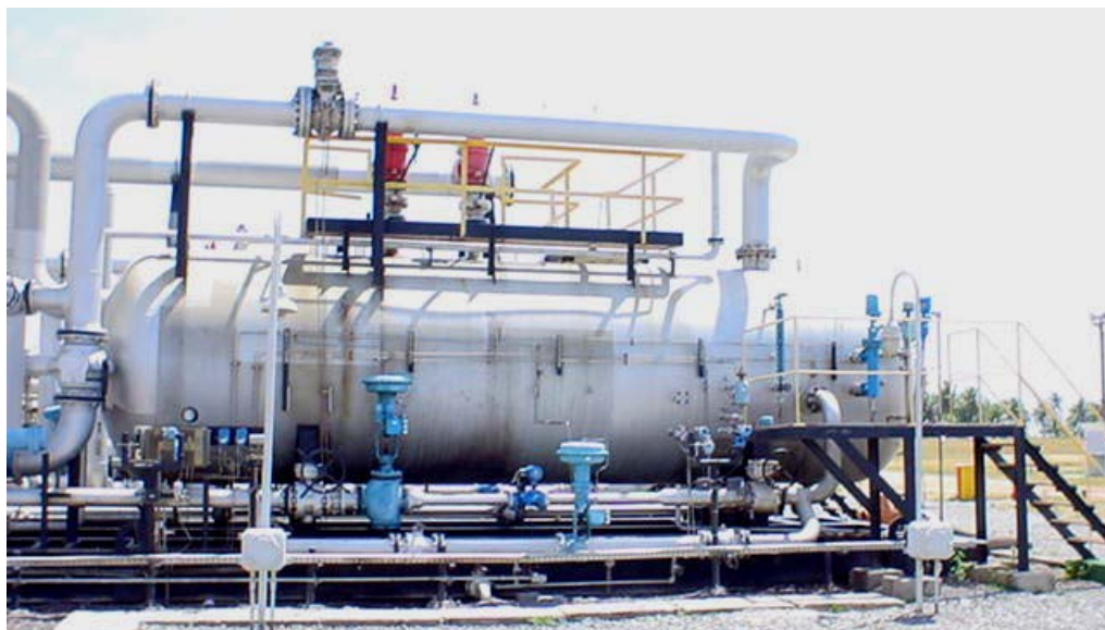
Figura 2.7 Foto de um Vaso Separador Trifásico Horizontal Gravitacional
