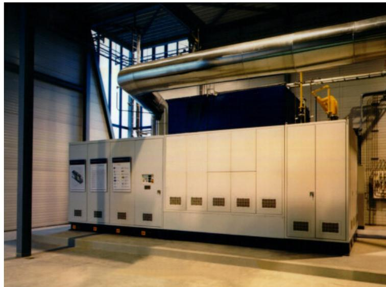
Figura 2.11 - Vista externa da unidade SOFC Siemens-Westinghouse 100kW Siemens Power Journal (2002)
