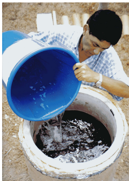
FIGURA 3.8 – Colocação da 1ª camada
