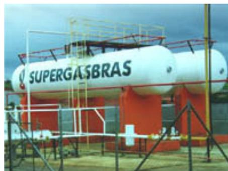
Fig: 3.5 - Uma Instalação de GLP a granel, de dois tanques de 38,0 m<sup>3</sup> (capacidade de 20 Ton de GLP cada)
