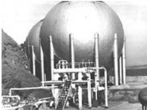
Fig. 3.1 – Esfera para armazenagem de GLP instalada em 1937, Santos – SP
