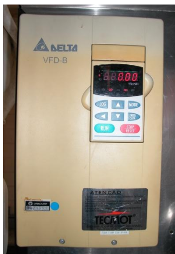
Figura 9 – Inversor de frequência
