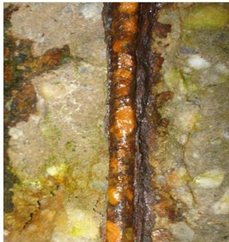
Figura 2.27 - Fotografia de dano ao concreto decorrente da corrosão da barra de aço num pilar do trapiche localizado em Magalhães Barata, município do nordeste do estado do Pará.
