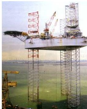
Figura 2.3: Plataforma Jackup (auto-elevatória). Unidade de produção do campo de Sable localizado no Canadá. (<<http://www.offshore-technology.com/projects/sable/index.html>>)
