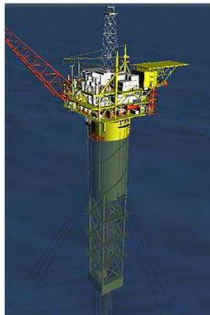
Figura 2.7: Ilustração de uma plataforma Spar utilizada para produzir o campo de gás Nansen Boomvang localizado no México. (<<http://www.offshore-technology.com/projects/nansen/index.html>>
